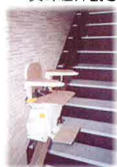
電動昇降機 (西側階段部分)
